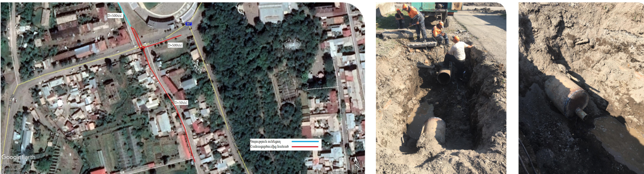
Արդյունքում շահագործումից հանվել են D=500մմ, L=100մ և D=50մմ, L=260մ ջրագծեր:
